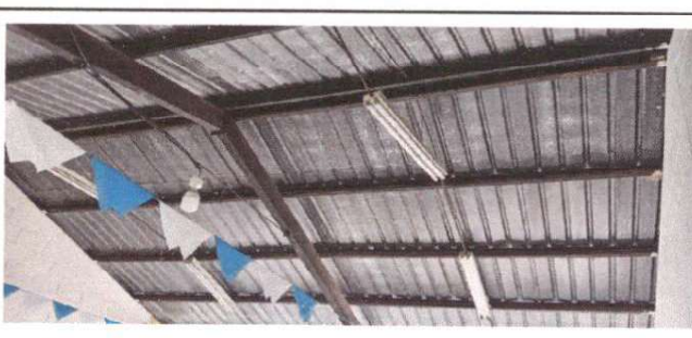
Foto 4: Mantenimiento a estructura de soporte de metal
