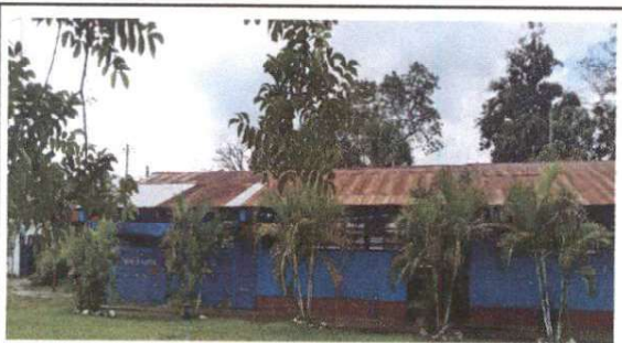
Foto 3: Sustrucción de elementos de fijación
