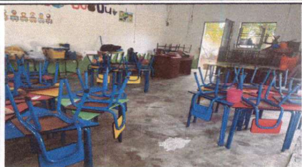
REPARACION DE PISO DE TORTA DE CEMENTO
