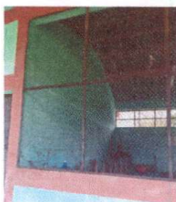
Sustitución de balcones de metal
