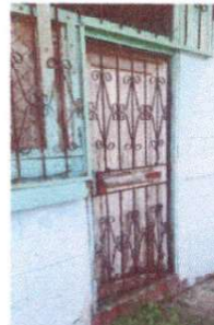
Sustitución de puerta
