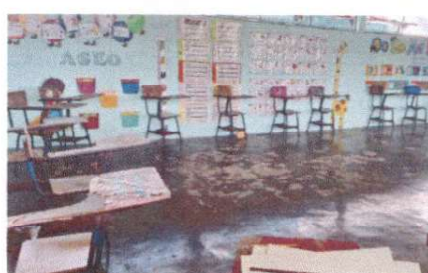
Sustitución de piso de cemento líquido
