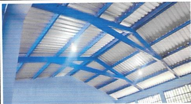
Foto 15: Sustitución de plafoneras
