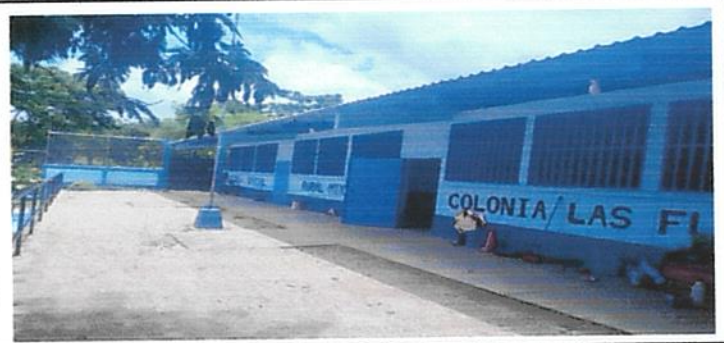
Foto 14: Sustitución de focos ahorradores
