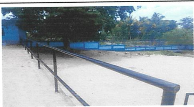
Foto 13: Mantenimiento a barandas de metal
