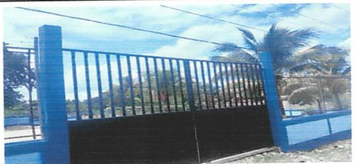
Foto 12: Mantenimiento a portones de metal
