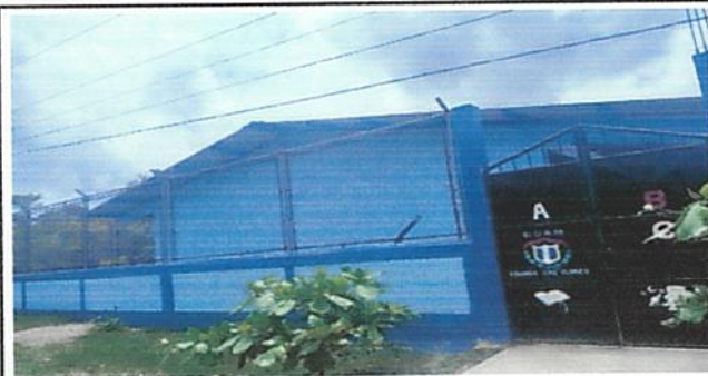
Foto 3: Pintura en muros exteriores e interiores
