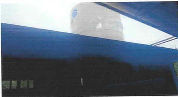
Foto 9: Sustrucción de depósito de agua 1100 lt
