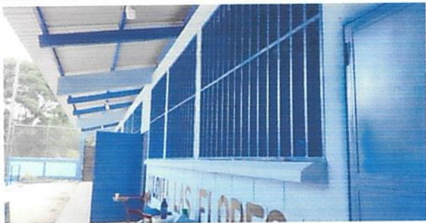
Foto 5: Mantenimiento a balcones de metal
