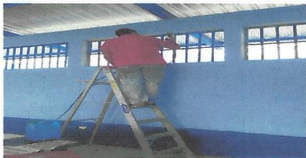
Foto 5: Mantenimiento a balcones de metal
