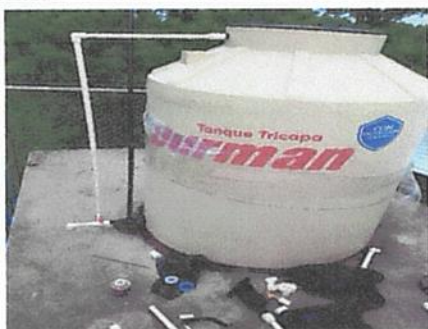
Foto 9: Sustitución de depósito de agua 1100 lt
