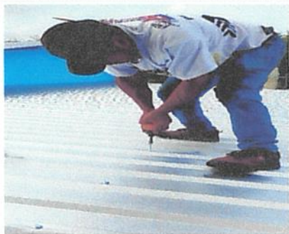
Foto1: Sustitución de lamina, por lamina troquelada aluzinc calibre 26
