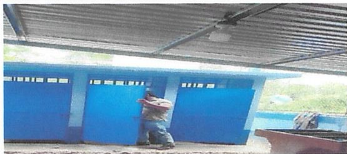
Foto 8: Mantenimiento a estructura (lijado, cambio de tubo, cepillado, sujeciones, aplicación de pintura) a puertas servicios sanitarios
