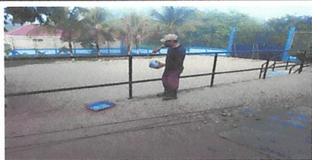
Foto 13: Mantenimiento a barandas de metal
