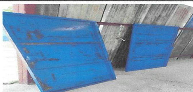
Foto 6: Mantenimiento a estructura (lijado, cambio de tubo, cepillado, sujeciones, aplicación de pintura)
