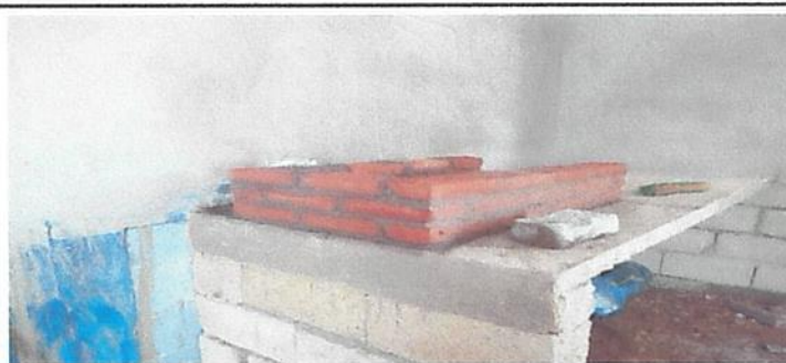
Foto 18: Sustitución de estufa rural (completa) incluye chimenea y plancha de metal
