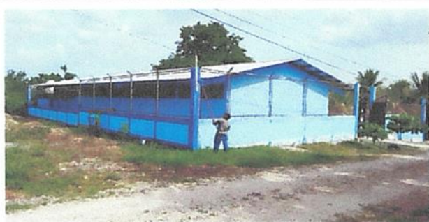
Foto 3: Pintura en muros exteriores e interiores
