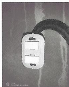
Foto 17: Reparación de cableado eléctrico
