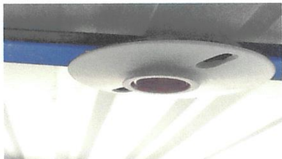
Foto 15: Sustitución de plafoneras
