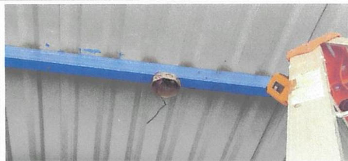
Foto 14: Sustitución de focos ahorradores
