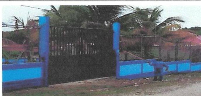
Foto 12: Mantenimiento a portones de metal
