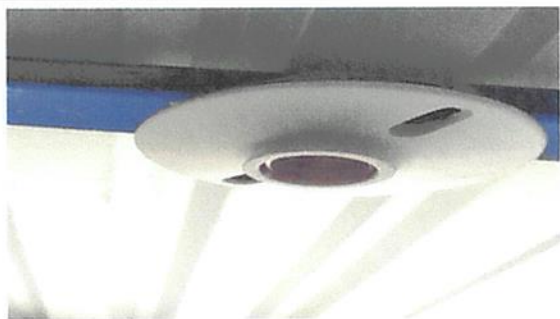
Foto 15: Sustitución de plafoneras
