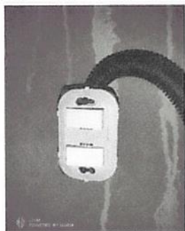
Foto 17: Reparación de cableado eléctrico
