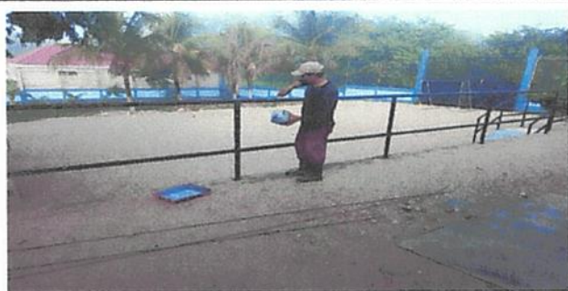
Foto 13: Mantenimiento a barandas de metal
