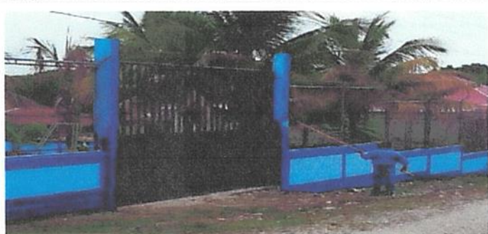
Foto 12: Mantenimiento a portones de metal
