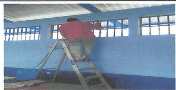
Foto 5: Mantenimiento a balcones de metal
