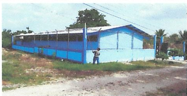
Foto 3: Pintura en muros exteriores e interiores
