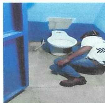
Foto 8: Mantenimiento a estructura (lijado, cambio de tubo, cepillado, sujeciones, aplicación de pintura) a puertas servicios sanitarios
