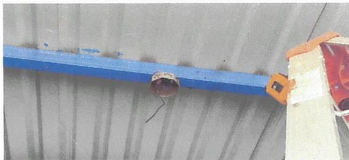
Foto 14: Sustitución de focos ahorradores
