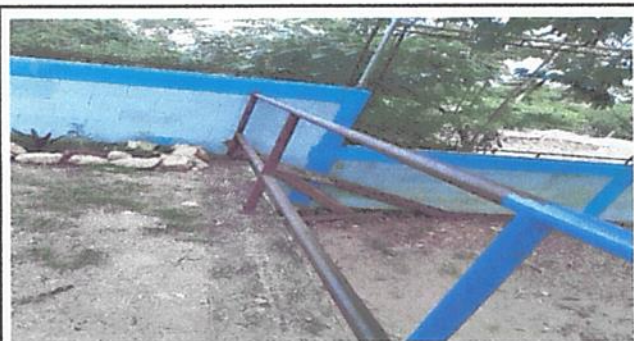
Foto 13: Mantenimiento a barandas de metal
