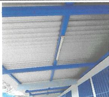
Foto 15: Sustitución de plafoneras
