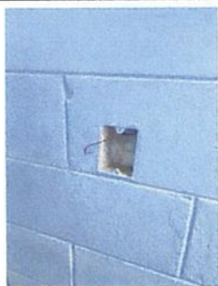
Foto 17: Reparación de cableado electrico
