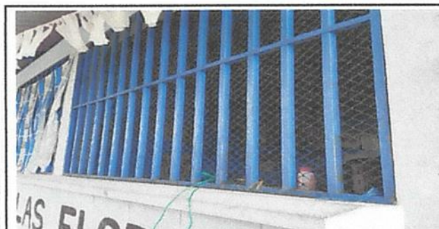
Foto 5: Mantenimiento a balcones de metal
