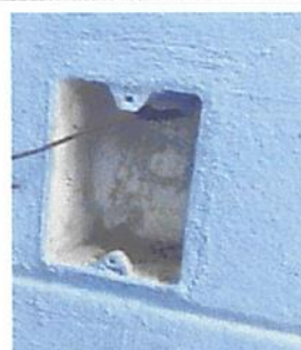
Foto 16: Sustitución interruptores dobles
