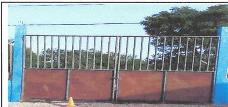
Foto 12: Mantenimiento a portones de metal
