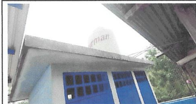
Foto 9: Sustitución de depósito de agua 1100 lt
