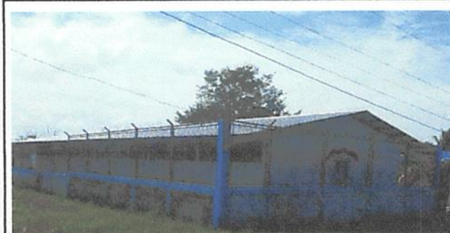
Foto 3: Pintura en muros exteriores e interiores
