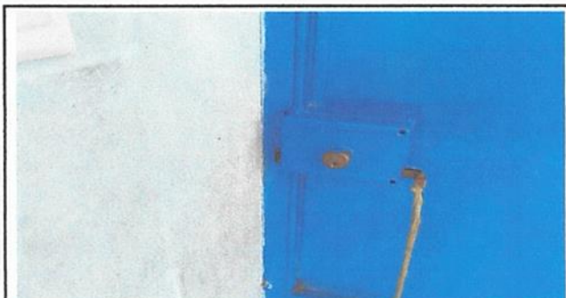
Foto 7: Sustitución de chapa
