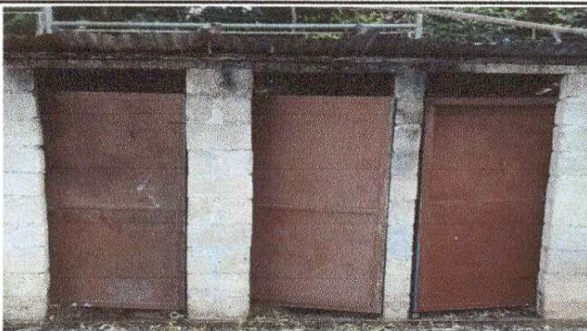
FOTO 3 Sustitución puertas sanitarios
