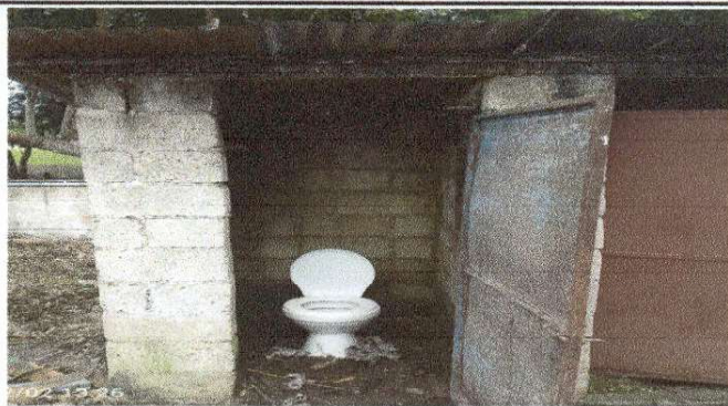
FOTO 1 Reparacion y mantenimiento de servicios sanitarios
