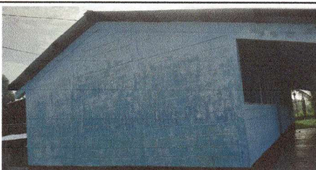
FOTO 5 Pintura en muros interiores y exteriores en aulas
