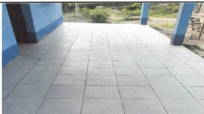
Foto 3: INSTALACION DE PISO CERAMICO
