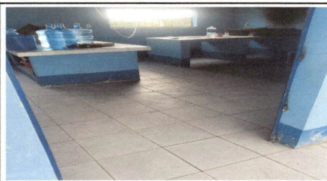
Foto 4: INSTALACION DE PISO CERAMICA EN ESTUFA RURAL
