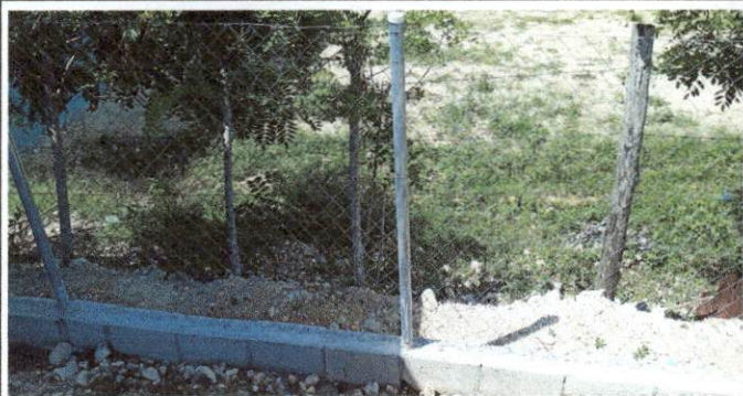
Foto 1: Reparación de tubo hg y malla galvanizada
