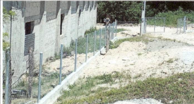
Foto 2: Reparación de tubo hg y malla galvanizada
