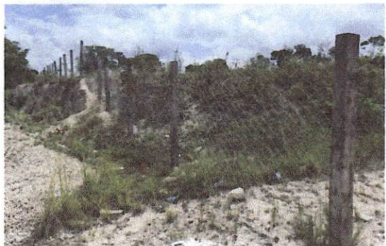
Foto 1: Reparación de tubo hg y malla galvanizada
