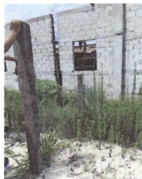
Foto 2: Reparación de tubo hg y malla galvanizada
