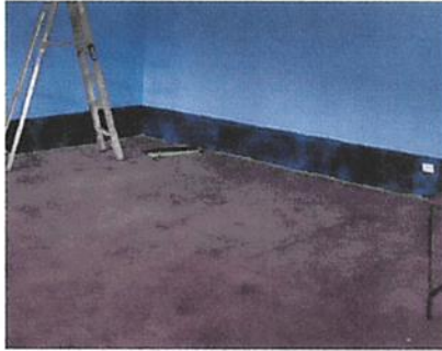
Foto 7 :INSTALACIÓN DE UNIDADES FUERZA(TOMACORRIENTE) INCLUYE CABLE ELÉCTRICO
