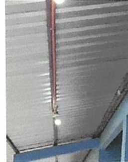
Foto: SUSTITUCIÓN DE ESTRUCTURA DE SOPORTE DE METAL, POR METAL
