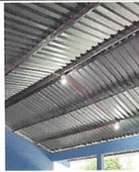
Foto: 4 INSTALACIÓN DE UNIDADES LUZ
