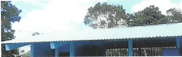
Foto 1: SUSTITUCIÓN DE LÁMINA, POR LÁMINA TROQUELADA ALUZING CALIBRE 26
