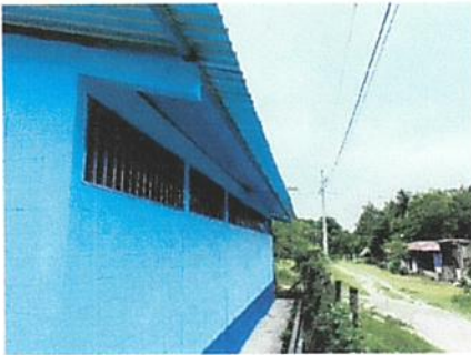
Foto: 3 PINTURA EN MUROS INTERIORES Y EXTERIORES
