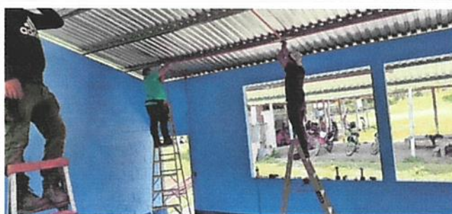
Foto: 4 INSTALACIÓN DE UNIDADES LUZ
