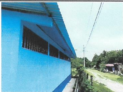
Foto: 3 PINTURA EN MUROS INTERIORES Y EXTERIORES
