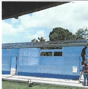
Foto: SUSTITUCIÓN DE ESTRUCTURA DE SOPORTE DE METAL, POR METAL
