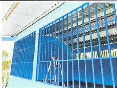
Foto: 5 FABRICACIÓN E INSTALACIÓN DE VENTANAS BALCÓN DE METAL
