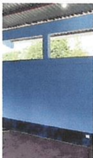
Foto 7 :INSTALACIÓN DE UNIDADES FUERZA(TOMACORRIENTE) INCLUYE CABLE ELÉCTRICO
