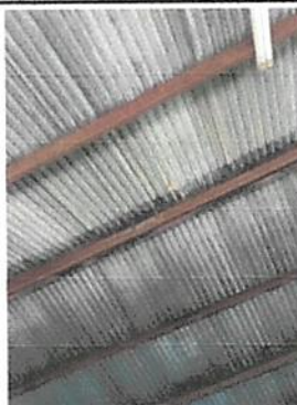
Foto: SUSTITUCIÓN DE ESTRUCTURA DE SOPORTE DE METAL, POR METAL
