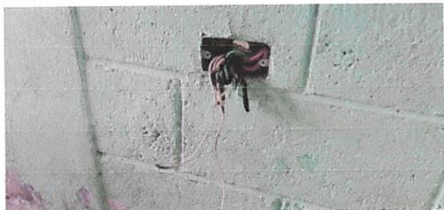
Foto 7 :INSTALACIÓN DE UNIDADES FUERZA(TOMACORRIENTE) INCLUYE CABLE ELÉCTRICO
