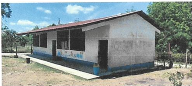
Foto: 3 PINTURA EN MUROS INTERIORES Y EXTERIORES
