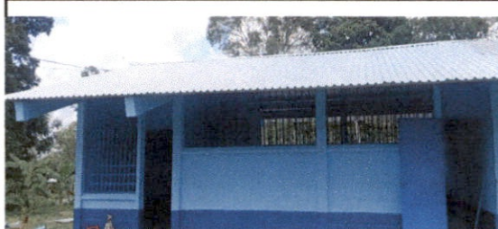
Foto 6: Sustitución de lámina, por lámina troquelada aluzinc calibre 26
