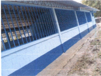
Foto1: Reparación de planchas de concreto de patio
