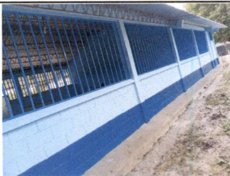
Foto1: Sustitución de estructura de metal de ventana
