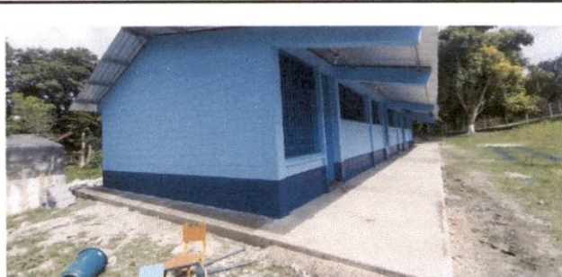
Foto 2: Sustitución de piso de torta de cemento
