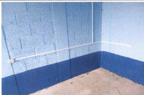
Foto 5: Sustitución de tomacorrientes dobles
