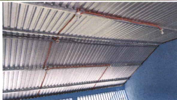
Foto 4: Reparación de cableado eléctrico
