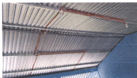
Foto 4: Reparación de cableado eléctrico
