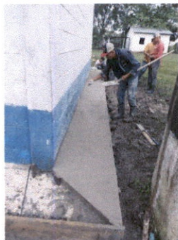
Foto1: Reparación de planchas de concreto de patio
