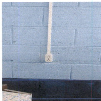
Foto 5: Sustitución de tomacorrientes dobles
