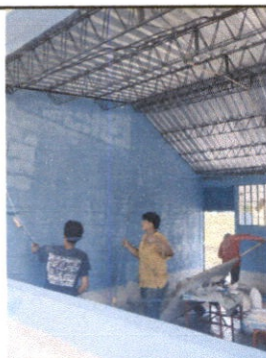
Foto 3: Pintura en muros exteriores e interiores
