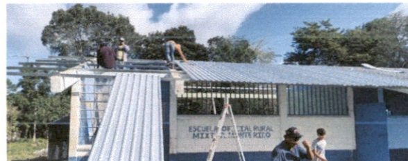
Foto 6: Sustitución de lámina, por lámina troquelada aluzinc calibre 26
