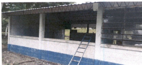
Foto1: Sustitución de estructura de metal de ventana
