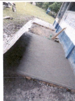
Foto 2: Sustitución de piso de torta de cemento
