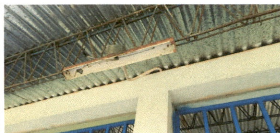
Foto 4: Reparación de cableado eléctrico
