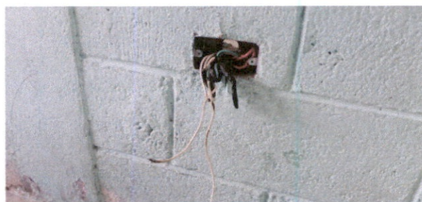
Foto 5: Sustitución de tomacorrientes dobles
