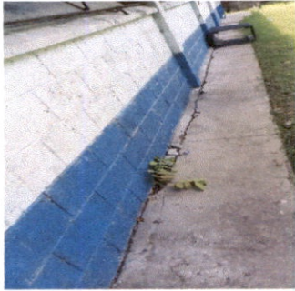
Foto1: Reparación de planchas de concreto de patio
