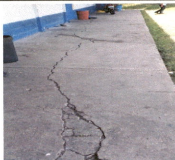
Foto 2: Sustitución de piso de torta de cemento
