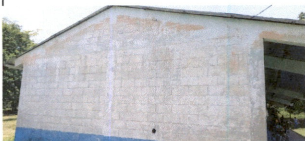
Foto 3: Pintura en muros exteriores e interiores
