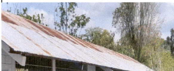
Foto 6: Sustitución de lámina, por lámina troquelada aluzinc calibre 26
