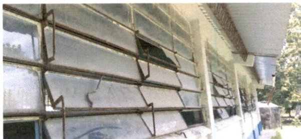
Foto1: Mantenimiento de estructura de metal de ventana
