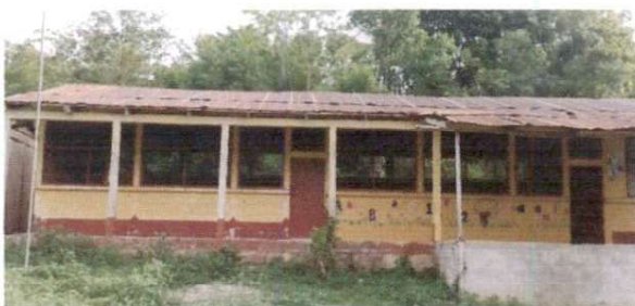
Foto 5: 9.1 Pintura en muros exteriores
