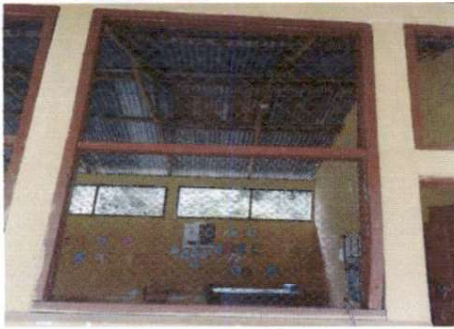
Foto 1: 19.2 Fabricación e instalación de balcones de hierro en ventana
