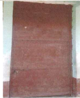
Foto 2: 19.3 Fabricación e instalación de puertas de metal en módulos
