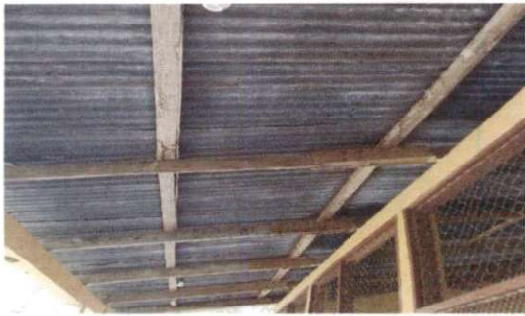
Foto 3: 2.2 Sustitución de estructura de soporte de madera, por metal
