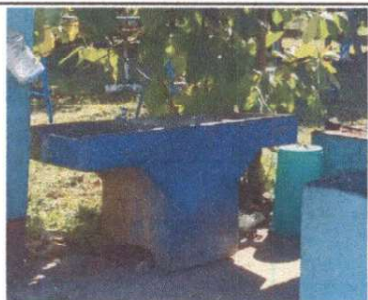
Instalación de pila
