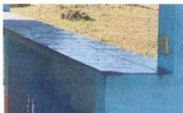
Instalación de unidades fuerza (tomacorriente), incluye cable eléctrico
