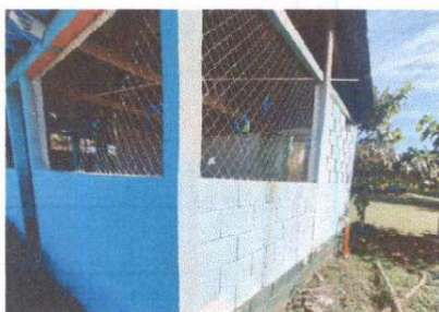
Sustitución de balcones de metal
