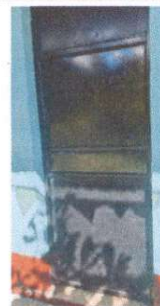
Sustitución de puerta
