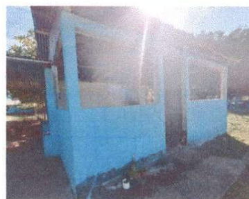
Pintura en muros exteriores e interiores
