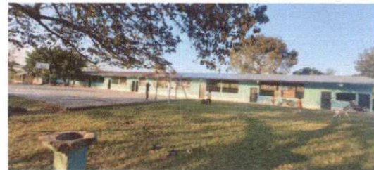
9.1 Pintura en muros exteriores e interiores
