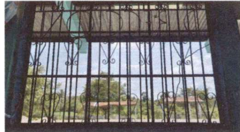
5.1 Mantenimiento a estructura de metal de ventana
