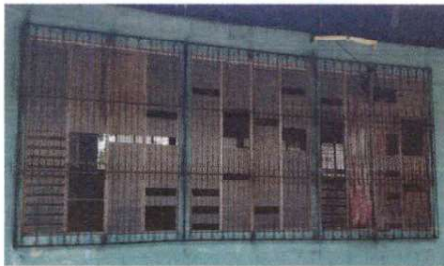
5.4 Sustitución de vidrio y mantenimiento a marcos de aluminio mill finish fabricación e instalación de ventana-balcon de metal
