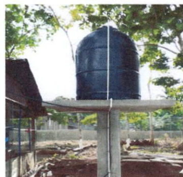
Foto: 4 Sustitución de estructura de metal , base de concreto para depósito de agua y suministro e instalación de depósito de 1700 litros
