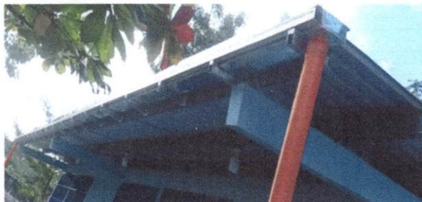
Foto: 5 Sustitución e instalación de canal
