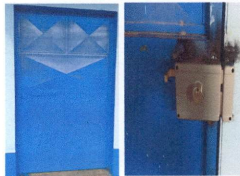
FOTO: 2 Mantenimiento a dos puertas de metal lijado, aplicación de pintura y sustitución de chapas
