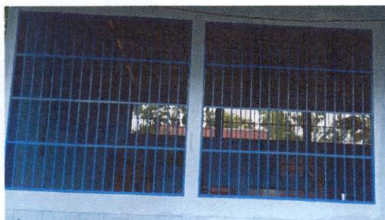
Foto 1: Mantenimiento a balcones de metal
