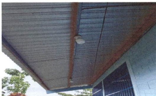
Foto: 3 Reparación de sistema eléctrico
