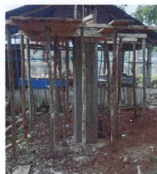
Foto: 4 Sustitución de estructura de metal , base de concreto para depósito de agua y suministro e instalación de depósito de 1700 litros
