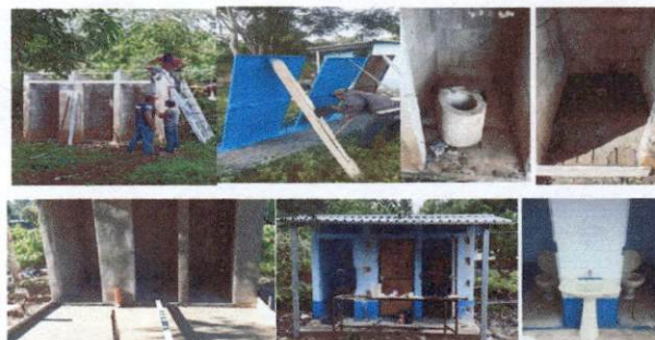
Foto: 6 Sustitución de estructura de madera por lamina troquelada aluzinc calibre 26, fabricación e instalación de tres puertas para baño, sustitución de inodoro por sanitarios lavables, pintura en muros exteriores e interiores, repello en muro y sustitución de lavamanos
