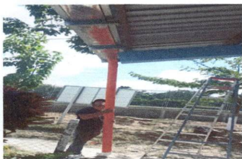
Foto: 5 Sustitución e instalación de canal
