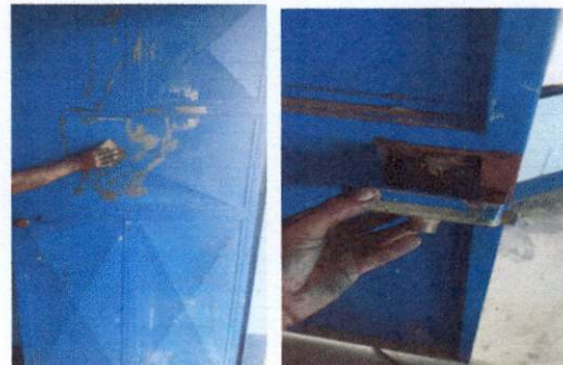
FOTO: Mantenimiento a dos puertas de metal lijado, aplicación de pintura y sustitución de chapas
