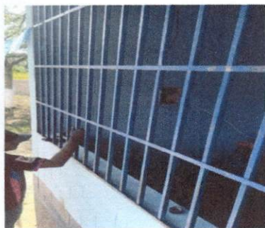
Foto 1: Mantenimiento a balcones de metal
