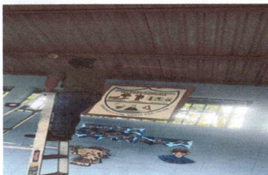
Foto: 3 Reparación de sistema eléctrico
