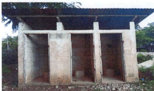
Foto: 6 Sustitución de estructura de madera por metal con lámina troquelada aluzinc calibre 26, fabricación e instalación de tres puertas para baño, sustitución de inodoro por sanitarios lavables, pintura en muros exteriores e interiores, repello en muro y sustitución de lavamanos
