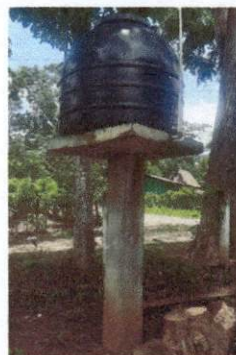
Foto: 4 Sustitución de estructura de metal , base de concreto para depósito de agua y suministro e instalación de depósito de 1700 litros
