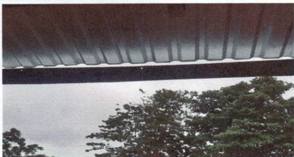
Foto: 5 Sustitución e instalación de canal
