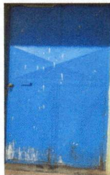
FOTO: Mantenimiento a dos puertas de metal lijado, aplicación de pintura y sustitución de chapas
