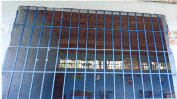
Foto 1: Mantenimiento a balcones de metal
