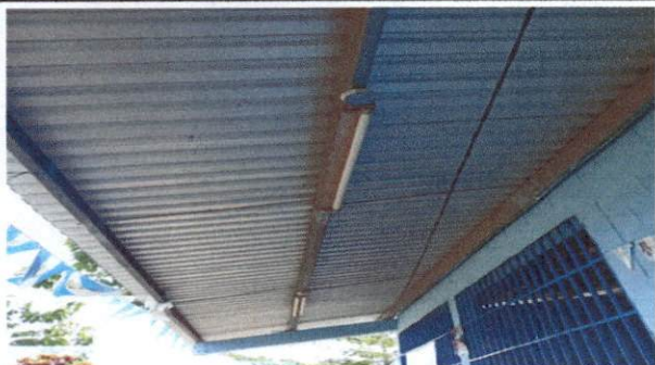
Foto: 3 Reparación de sistema eléctrico
