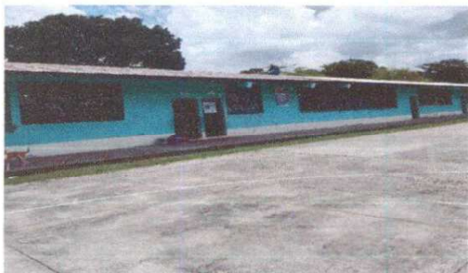
Foto1: Reparación de cableado electrico
