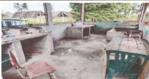
Foto 9: Sustrucción de piso de torta de concreto
