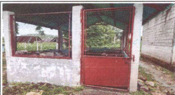
Foto 7: Sustrucción de puerta
