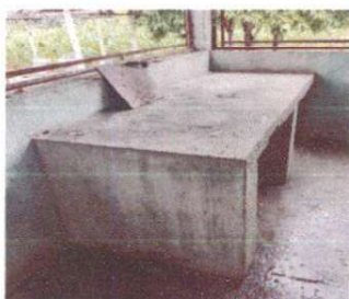
Foto 5:Instalación de azulejo en estufa rural
