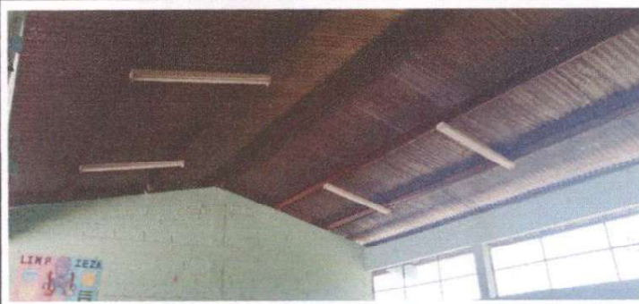
Foto 4: Mantenimiento a estructura de soporte de metal
