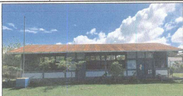
Foto 1: . 1.1 Sustitución de lamina, por lamina troquelada aluzinc calibre 2
