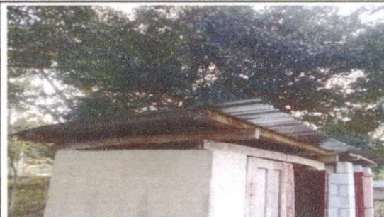
Sustitución de lámina, por lámina troquelada
