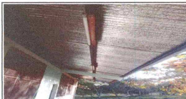
Reparación de sistema eléctrico
