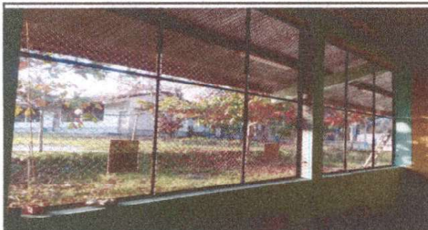
Fabricación e instalación de ventana-balcon de metal
