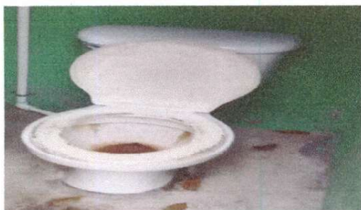
Sustitución de inodoro
