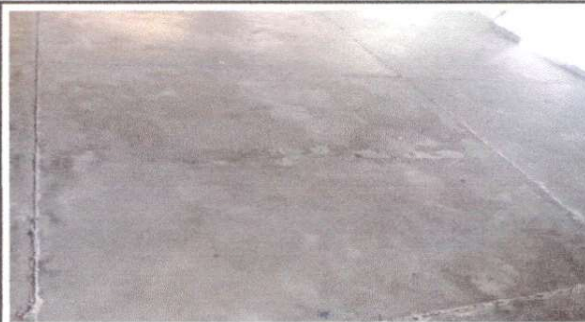
sustitución de piso de torta de concreto
