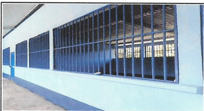
Foto 3: PINTURA EN MUROS INTERIORES Y EXTERIORES
