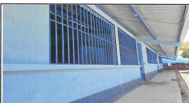
Foto 6: SUSTITUCIÓN DE BALCONES DE METAL
