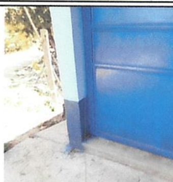
Foto 2: MANTENIMIENTO A ESTRUCTURA DE PUERTA
