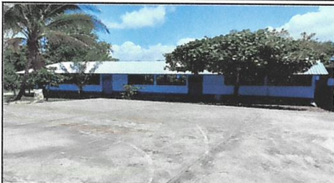
Foto 1: SUSTITUCION DE LAMINA POR LAMINA GALVANIZADA ALUZINC
