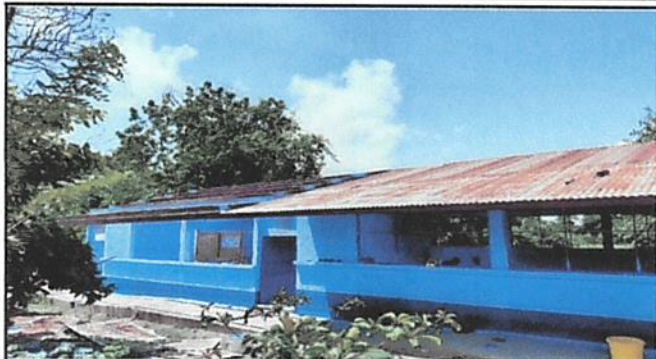
Foto 1: SUSTITUCION DE LAMINA POR LAMINA GALVANIZADA ALUZINC
