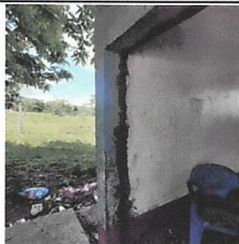
Foto 2 MANTENIMIENTO A ESTRUCTURA DE PUERTA
