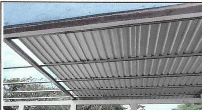
Foto: 4 MANTENIMIENTO DE ESTRUCTURA DE TECHO DE METAL
