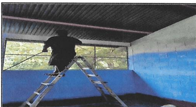
Foto: 3 PINTURA EN MUROS INTERIORES Y EXTERIORES
