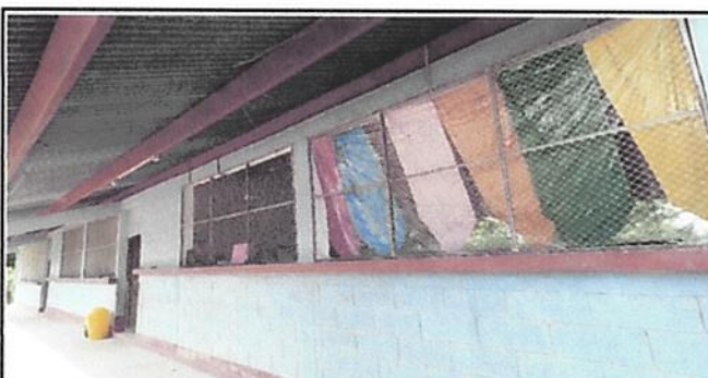
Foto 6: SUSTITUCIÓN DE BALCONES DE METAL
