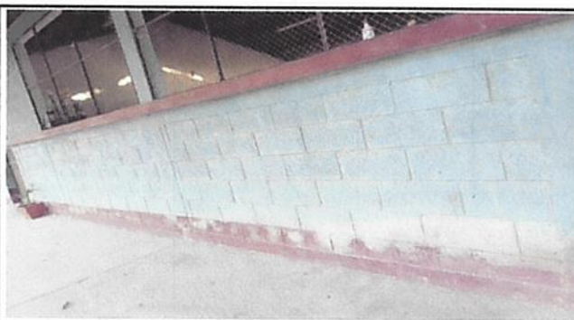
Foto 3: PINTURA EN MUROS INTERIORES Y EXTERIORES
