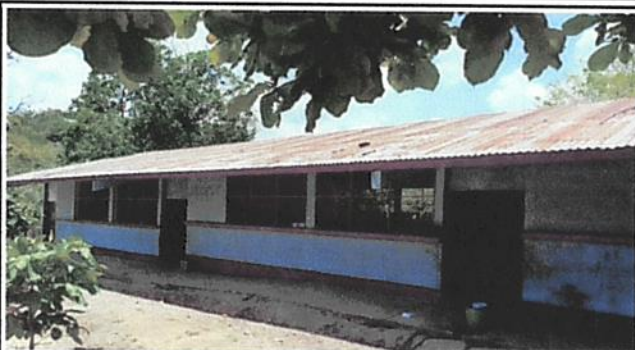
Foto 1: SUSTITUCION DE LAMINA POR LAMINA GALVANIZADA ALUZINC
