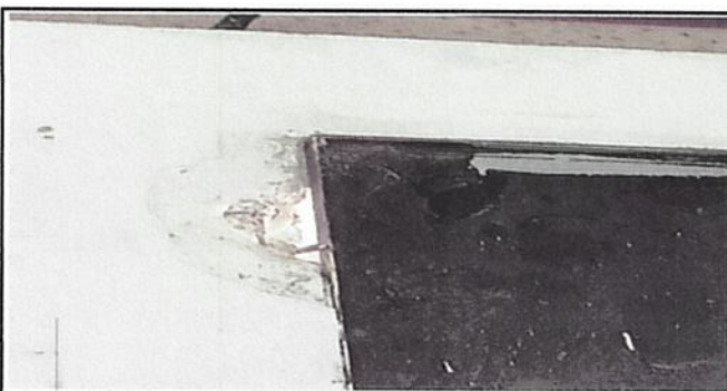
Foto 5: SELLADO DE GRIETAS Y FISURAS EN MUROS
