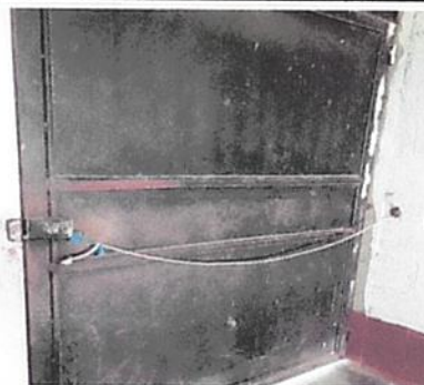
Foto 2: MANTENIMIENTO A ESTRUCTURA DE PUERTA
