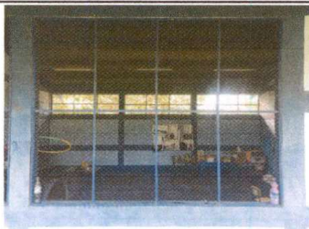
Foto 3: 5.6 SUSTITUCIÓN DE BALCONES DE METAL
