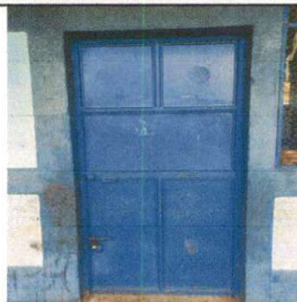
Foto 2: 4.3 SUSTITUCIÓN DE PUERTA DE METAL
