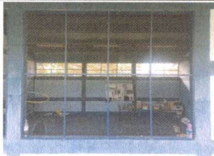
Foto 3: 5.6 SUSTITUCIÓN DE BALCONES DE METAL
