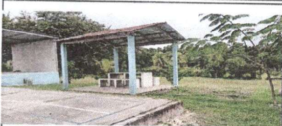
Sustitución de lámina, por lámina troquelada aluzinc calibre 26
