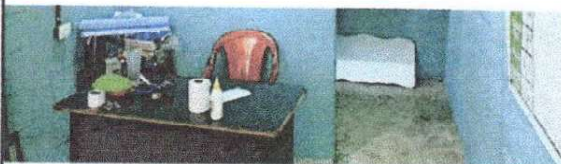
Sustitución de piso cerámico (antideslizante)
