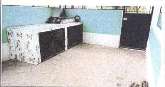
Sustitución de piso cerámico (antideslizante)
