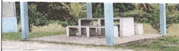
Reparación de piso de torta de concreto
