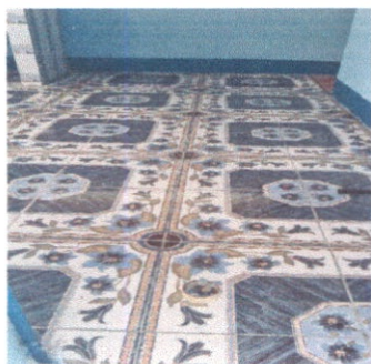
Foto 3:Sustitución de piso cerámico
