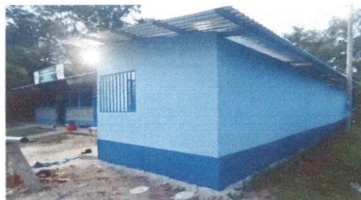
Foto 8: Repello en muro y pared
