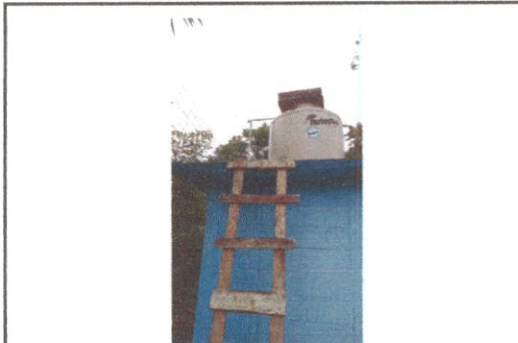
Foto13:Sustitución de depósito de agua 1100 lt
