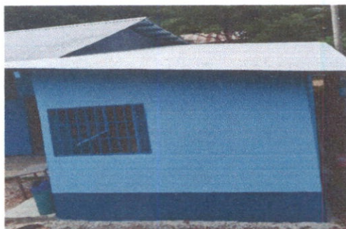
Foto1: Sustitución de lamina, por lamina troquelada aluzinc calibre 26 en cocina
