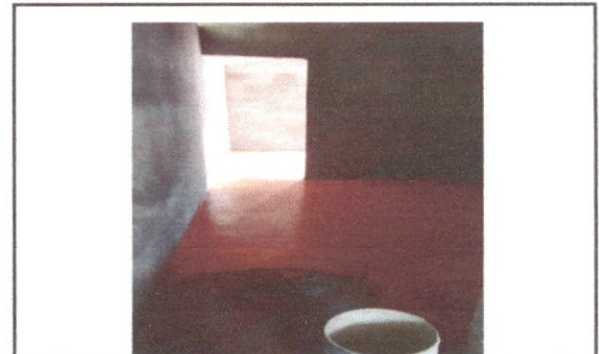
Foto 16: Sustitucion de piso de torta de concreto.
