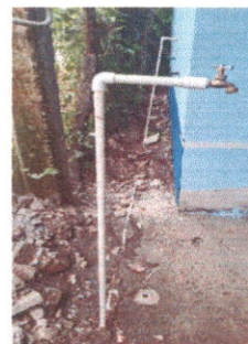
Foto 12: Sustitución de tubería línea principal con yave de paso y chorro
