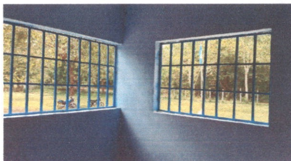
Foto 4: Sustitución de balcones de metal
