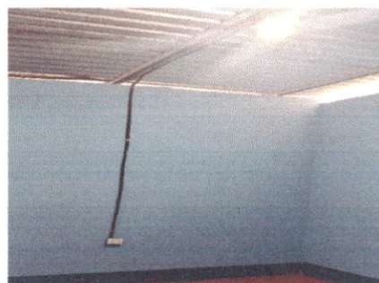
Foto 10: Instalación de unidades de luz y fuerza (incluye interruptor, plafonera, foco, tomacorriente, ducto y cable eléctrico)
