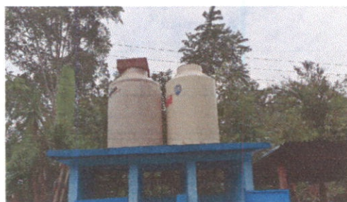
Foto13:Sustitución de depósito de agua 1100 lt
