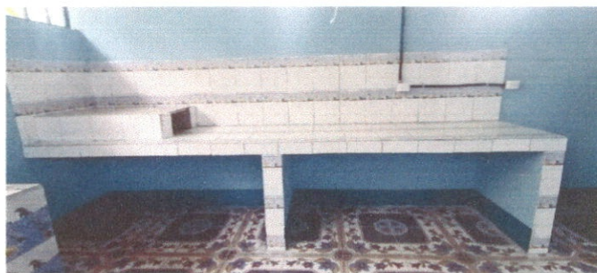
Foto 6: Mantenimiento a estufa rural
