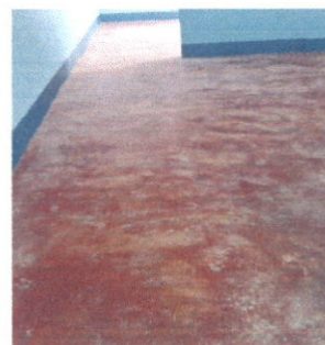
Foto 16: Sustitucion de piso de torta de concreto.
