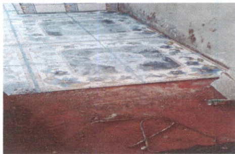
Foto 3: Sustrucción de piso cerámico
