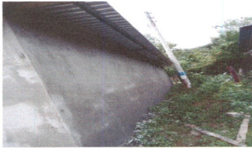
Foto1: Sustrucción de lamina, por lamina troquelada aluzinc calibre 26 en cocina
