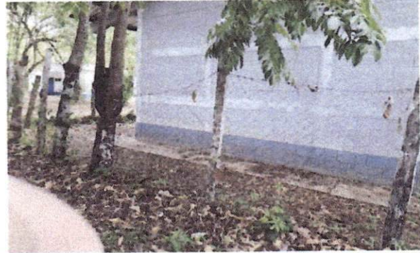
Foto 2: Reparación de tubo hg y malla galvanizada
