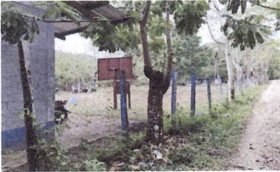
Foto 1: Reparación de tubo hg y malla galvanizada
