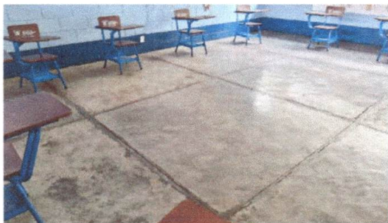
Foto 7: Reparación de piso y suministro de piso cerámico.
