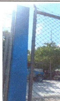
Foto 4: Reparación de tubo hg y malla galvanizada en zonas dañadas.
