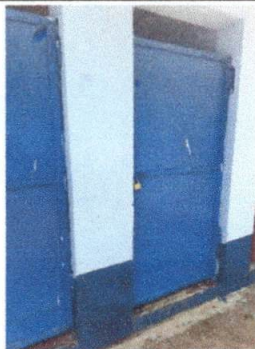
Foto 1: Mantenimiento a puertas
