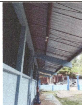
Foto 10: Sustitución de lamparas tipo LED.
