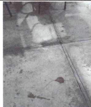
Foto 8: Reparación de piso y suministro de piso cerámico.
