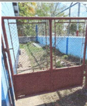
Foto 3: Mantenimiento a porton de metal
