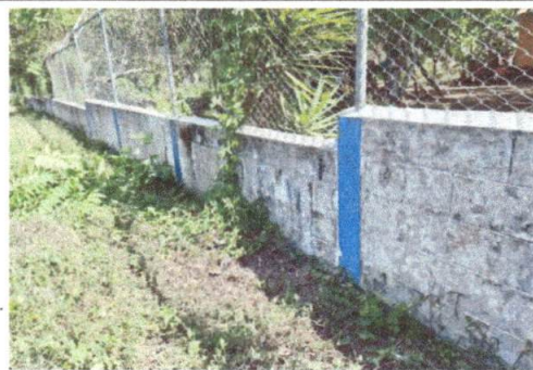
Foto 2: Pintura en muros exteriores
