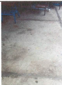
Foto 9: Reparación de piso y suministro de piso cerámico.
