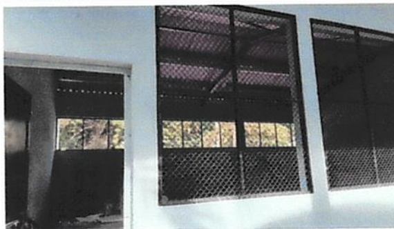
Foto: Mantenimiento a balcones de metal
