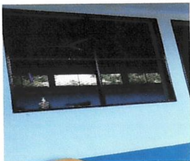
Foto 1: Sustrucción de estructura de metal de ventana
