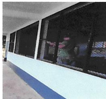
Foto: Mantenimiento a balcones de metal
