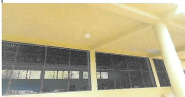
Foto: Mantenimiento a balcones de metal
