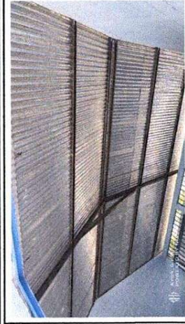
Foto 1: Sustitución de lamina, por lamina troquelada aluzinc calibre 26 modulo de aulas
