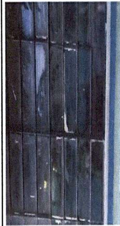
Foto 5: Sustitución de ventanas por marcos de aluminio mas vidrio
