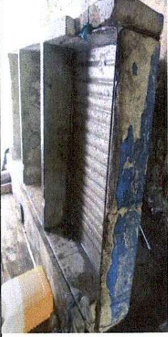
Foto 4: Sustitución de pila de cemento de un lavadero
