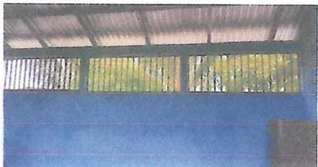
Foto 1: Sustrucción de ventana de madera por metal más vidrio
