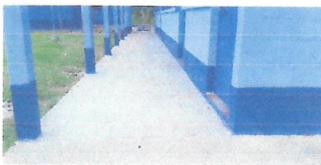
Foto 2: Sustrucción de piso de torta de concreto
