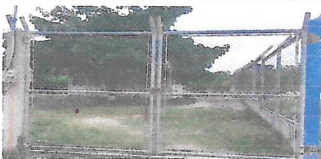
Foto 6: Mantenimiento portones de metal
