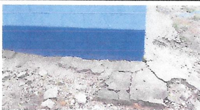
Foto 4: Reparación de banquetas de concreto
