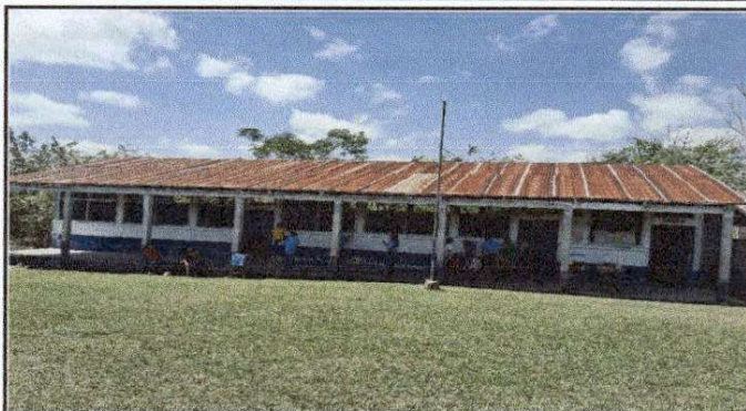
Foto 1: . Sustitución de lámina, por lámina troquelada
