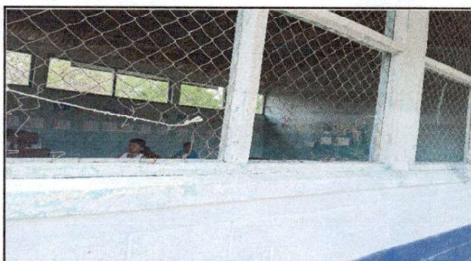
Foto 4: Sustitución de estructura de metal de ventanas
