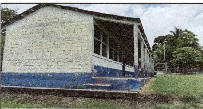
Foto 5: Pintura en muros exteriores e interiores
