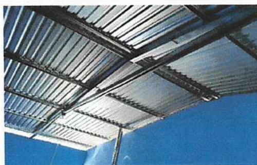
Foto 6: Sustitución de ductos + accesorios
