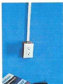
Foto 5: Sustitución de interruptores simples Y Sustitución de tomacorrientes dobles
