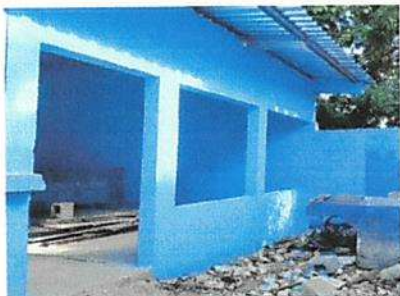
Foto 1: Pintura en muros exteriores e interiores
