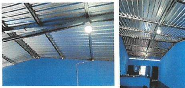
Foto 4: Reparación de lamparas tipo LED Y Sustitución de plafoneras
