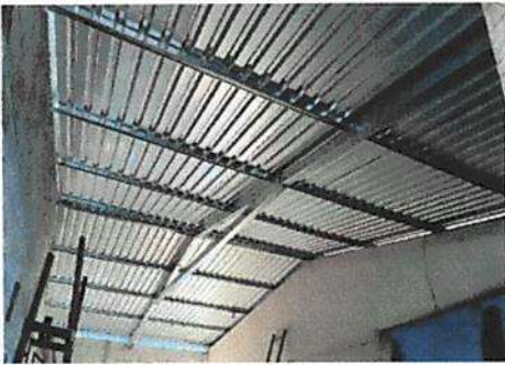
Foto: 3 Sustitución de elemento de fijación. Sustitución de estructura de soporte de madera, por metal troquelada calibre 26
