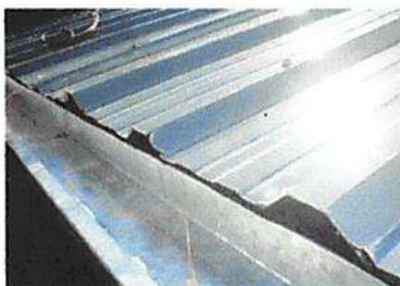
Foto 2: Sustitución de canal de pvc
