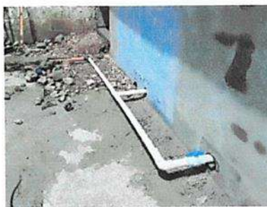
Foto 2: Sustitución de tubería lineal principal aguas purviales (3pul o 4 pulg)
