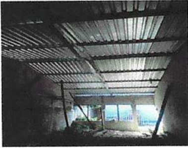
Foto 1: Sustitución de lámina, por lámina troquelada aluzin calibre 26 de la cocina
