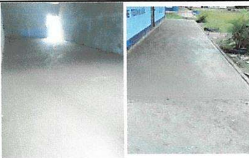
Foto: 5 Sustitución de piso de torta cerámica
