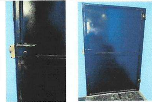
Foto: 4 Sustitución de chapas. Sustitución de puertas
