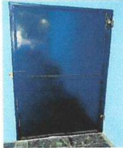
Foto: 2 Fabricacion e instalación de puertas de metal en módulos
