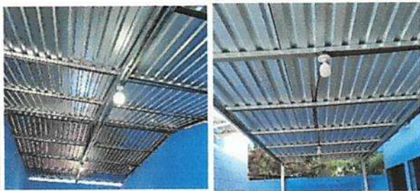
Foto: 3 Instalación de unidades luz (incluye interruptor, ducto y cable eléctrico)
