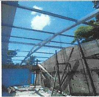
Foto 3: Sutiación de elemento de fijación. Sutiación de estructura de soporte de madera, por metal troquelada calibre 26
