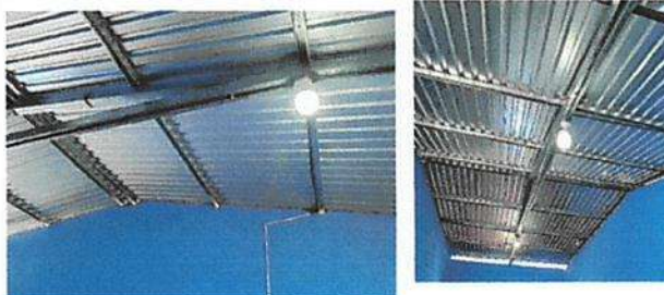
Foto: 4 Reparación de lamparas tipo LED Y Sustitución de plafoneras
