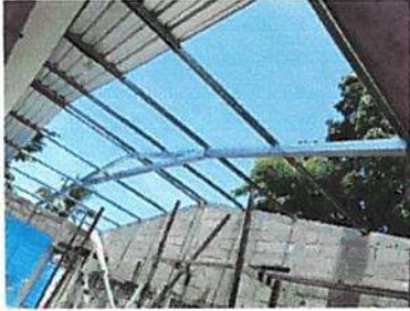
Foto 1: Sutiación de lámina, por lámina troquelada aluzin calibre 26 de la cocina
