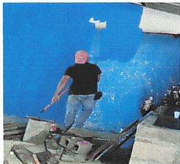
Foto 1: Pintura en muros exteriores e interiores
