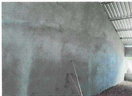
Foto 1: Repello en muro
