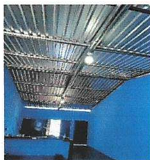
Foto 3: Instalación de unidades luz (incluye interruptor, ducto y cable eléctrico)
