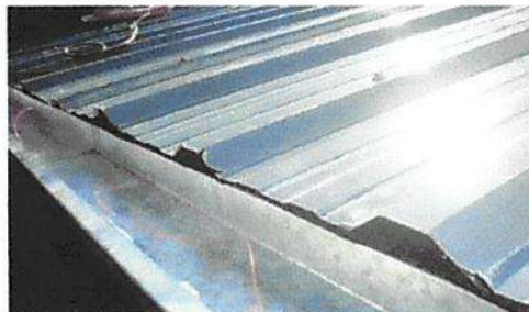
Foto 2: Sustitución de canal de pvc
