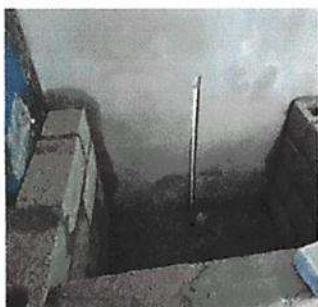
Foto: 3 Sustitución de tubería línea principal Y Sustición de llave de chorro
