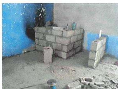
Foto 6: Sustitución de pila de cemento de un lavadero
