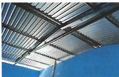
Foto: 6 Sustitución de ductos + accesorios
