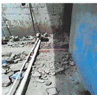
Foto 2 Sustitución de tubería lineal principal aguas puviales (3pul o 4 pulg)
