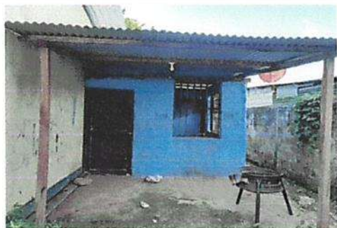
Foto 1: Sución de lámina, por lámina troquelada aluzin calibre 26 de la cocina
