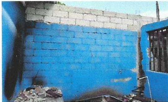
Foto 1: Pintura en muros exteriores e interiores /
