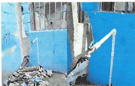
Foto 4: Instalación de tubería para agua potable Y Instalación de chorro
