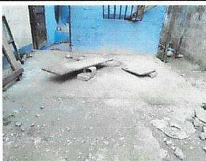
Foto 6: Sustitución de piso de torta cerámica
