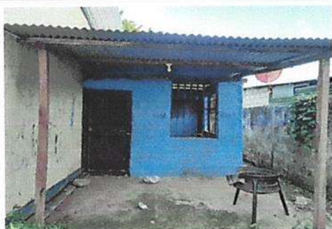
Foto 3: Instalación de unidades luz (incluye interruptor, ducto y cable eléctrico)
