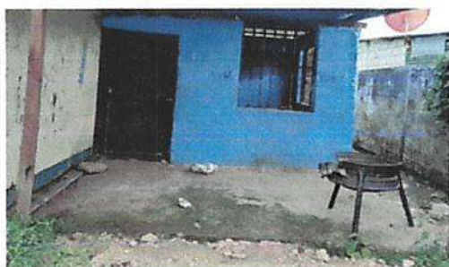
Foto 5: Sustitución de piso de torta cerámica
