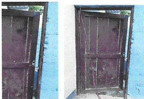
Foto 4: Sustitución de chapas. Sustitución de puertas
