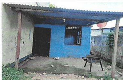
Foto 3: Sustitución de elemento de fijación. Sustitución de estructura de soporte de madera, por metal troquelada calibre 26
