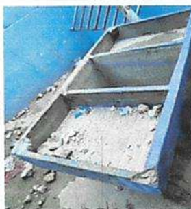
Foto 6: Sustitución de pila de cemento de un lavadero
