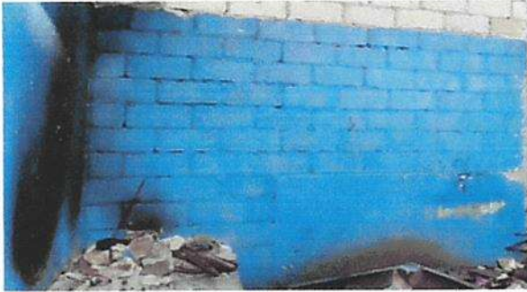
Foto 1: Repello en muro
