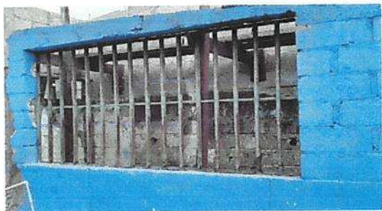
Foto 1: Fabricación e instalación de ventana-balcon de metal Y Fabricación e instalación de balcones de hierro en ventana
