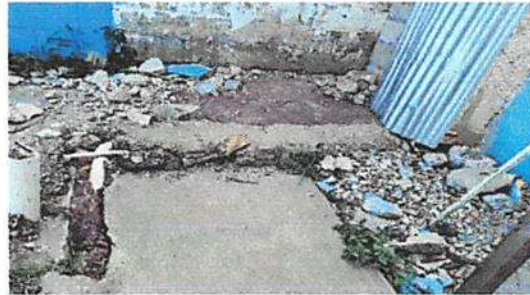
Foto 2 Sustitución de tubería lineal principal aguas puviales (3pul o 4 pulg) /
