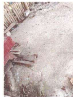
FOTO 10 Sustitucion de Piso de Torta de Concreto
