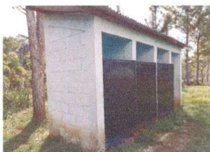
FOTO 3 Pintura de puertas de servicio sanitario
