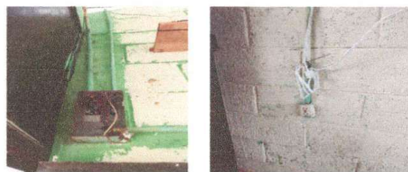
FOTO 6 Reparación de sistema eléctrico
