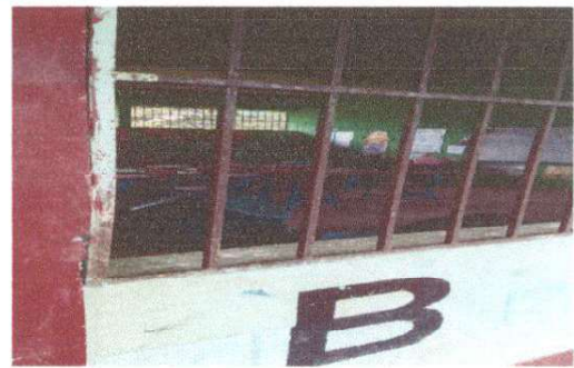
FOTO 8 Mantenimiento a balcones de metal
