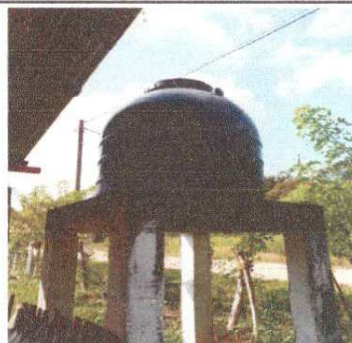
FOTO 4 Sustitución de deposito de agua
