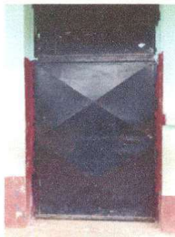
FOTO 9 Mantenimiento a puertas de metal
