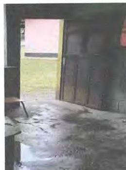
Foto: 5 SUSTITUCION DE PUERTA (4.3)
