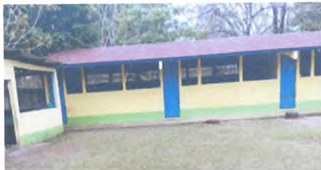
Foto: 3 MANTENIMIENTO A ESTRUCTURA (lijado, aplicación de pintura) (4.1)
