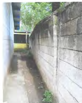
Foto: 10 REPARACION DE MURO PERIMETRAL DE BLOCK (15.1)
