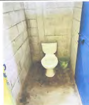
Foto: 8 SUSTITUCION INODORO (10.3)
