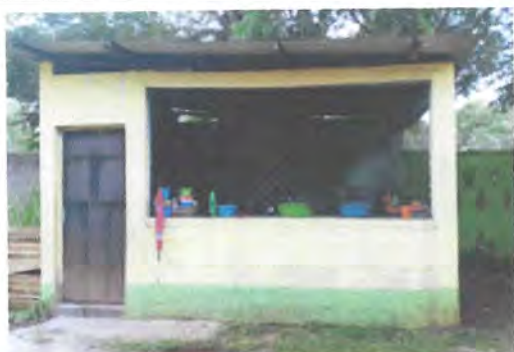
Foto 1 SUSTITUCION DE LAMINA POR LAMINA TROQUELADA ALUZINC CALIBRE 26 (1.1)
