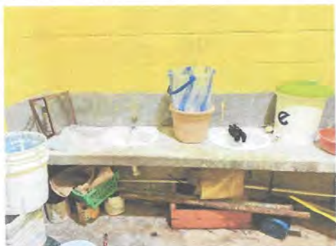
Foto: 9 SUSTITUCION DE LAVAMANOS (10.5)
