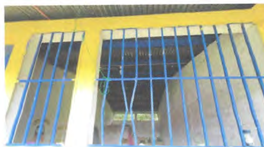
Foto: 6 SUSTITUCION DE BALCONES DE METAL (5.6)
