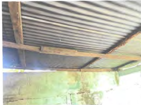
Foto: 2 SUSTITUCION DE ESTRUCTURA DE SOPORTE DE MADERA, POR METAL (2.2)
