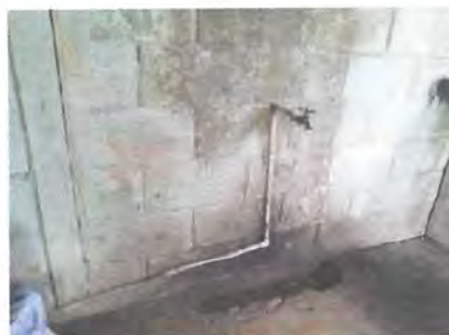
foto 12 INSTALACION DE PILA
