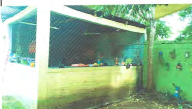
Foto 14 REPELLO EN MUROS (COCINA POR DENTRO Y DE DOS LADOS POR FUERA
