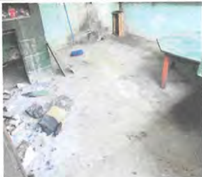
Foto 7 SUSTITUCION DE PISO DE CONCRETO (6.5)
