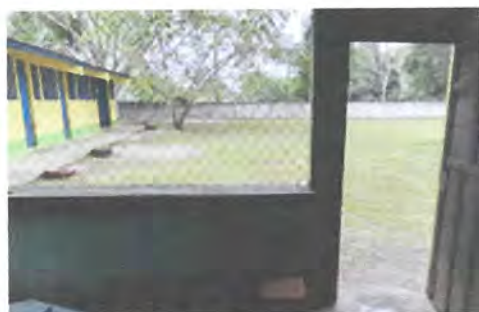
Foto 11 FABRICACION E INSTALACION DE VENTANA-BALCON DE METAL
