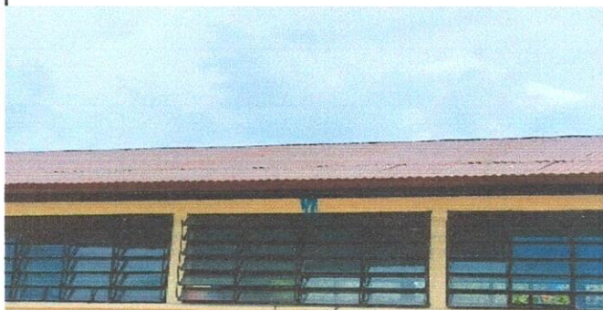
FOTO 1. SUSTITUCIÓN DE LAMINA, POR LAMINA TROQUELADA ALUZING CALIBRE 26
