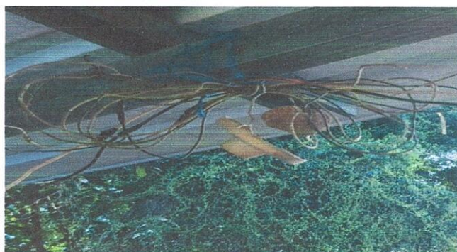
FOTO 3 SUSTITUCION DE PLAFONERAS
