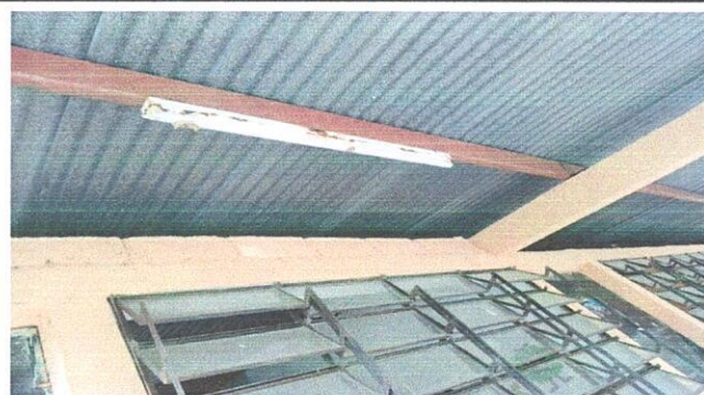
FOTO 4. SUSTITUCION DE FOCOS AHORRADORES
