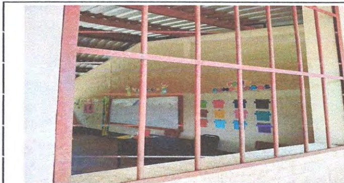
foto 2. mantenimiento a balcones de metal
