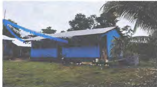
Foto: Mantenimiento de lámina troquelada aluzinc calibre 26
