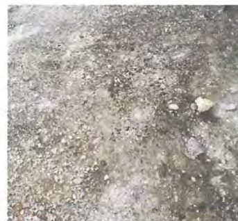
Foto: 6 Sustitución de piso de torta de concreto
