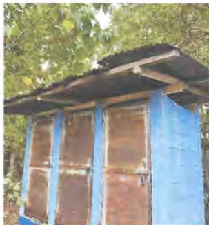
Foto: 3 Sustitución de estructura portante de madera, por metal.
