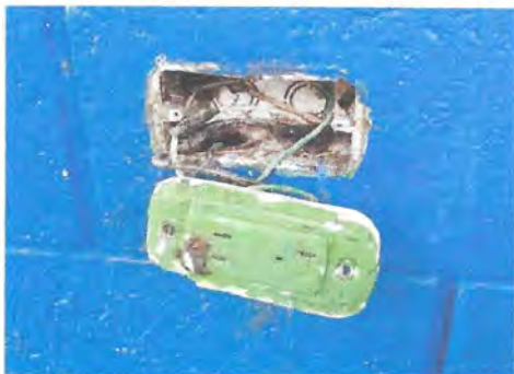
Foto 13: Sustrucción de tomacorrientes dobles
