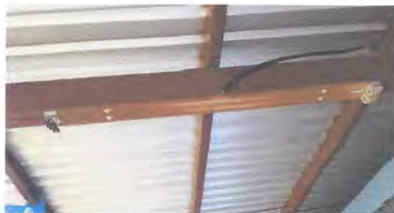
Foto 11: Sustitución de lamparas tipo LED
