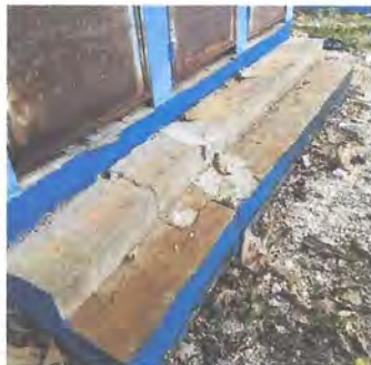
Foto: 5 Reparación de piso de torta de concreto
