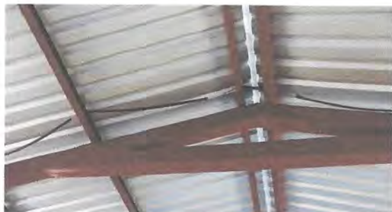
Foto 15: Reparación de cableado eléctrico
