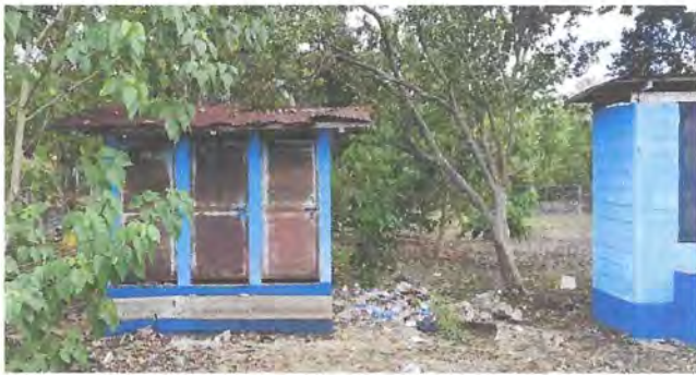
Foto 1: Sustitución de lámina troquelada aluzinc calibre 26
