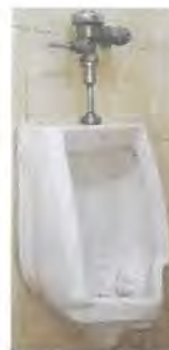
Foto 10: Sustitución de mingitorio.
