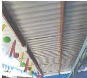
Foto: 4 Sustitución de estructura portante de metal por metal
