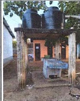
Foto: 2 sustitucion de tinaco por uno de 2500lts
