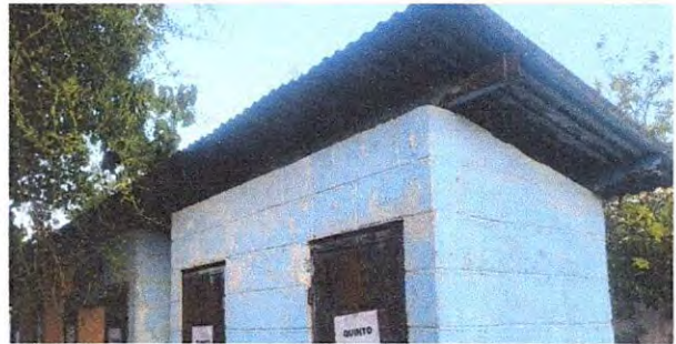
Foto 2: Sustrucion de estructura de metal por metal
