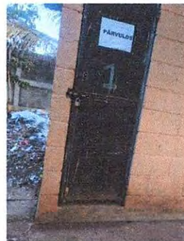
Foto 4: SUSTITUCION de puestes de baños
