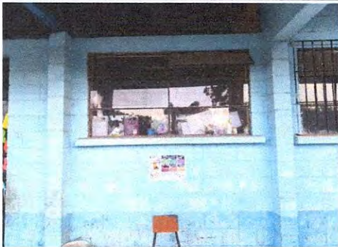
Foto 3: Sustrucion de ventanas de vidrio por valcones
