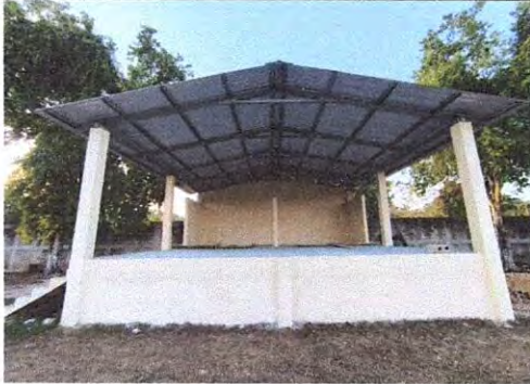
Foto 1: Sustitucion o instalacion de sisteme electrico en esenario de actividades
