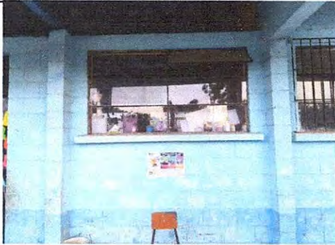
Foto: 4 Pintura de de todas las aulas fuera y dentro.
