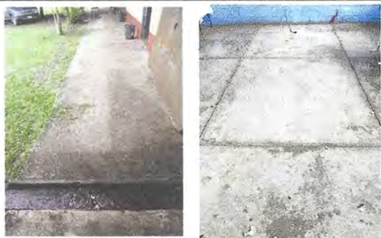
Foto: 3 Sustitucion de piso de torta de concreto, nivelacion de piso para poner el ceramico y Mejoramiento de piso de torta de concreto a piso ceramico.
