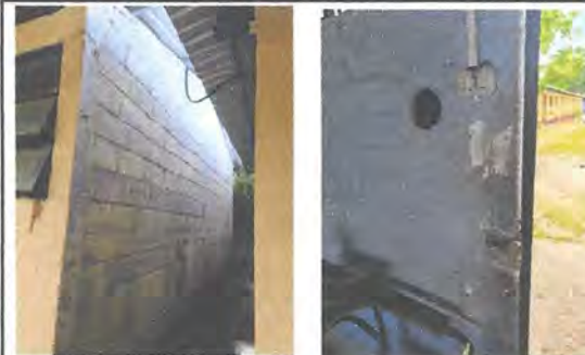
Foto: 6 Repello en muro
