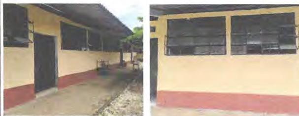
Foto 2 Sustitucion de balcones de metal y vidrio por Metal
