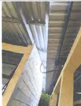
Foto: 4 Instalacion de canal de pvc con todos sus accesorios y bajadas de agua
