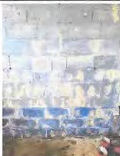
Foto: 5 Pintura en muros exteriores e interiores
